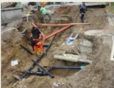
Viele Einbauten für Infrastruktur wie Wasser, Kanäle, Strom, Leerverrohrungen, Straßenbeleuchtung, usw. wurde mitverlegt. Dies erklärt auch die Bauverzögerung. "Besser jetzt, als noch einmal graben" - Danke der Köstendorfer Bevölkerung für das Verständnis
