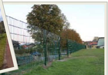
Die Zaunanlage bei der Sportanlage der Neuen Mittelschule wurde durch einen stabilen Doppelstabgittermattenzaun ersetzt
